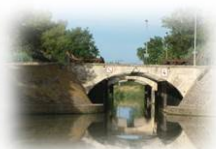
Les Ouvrages du Libron
