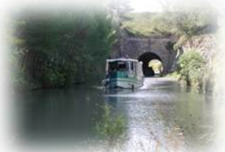
Le Tunnel du Malpas
